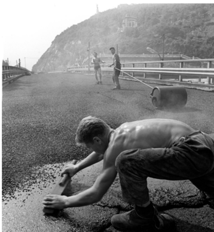
Budapest, 1964. július 15. Az Erzsébet híd utolsó pályaszerkezeti elemét is a helyére emelték, így a híd már összeköti Pestet és Budát. Ezzel egyidőben megkezdtek a hídfeljáró utak aszfaltozását. A képen: aszfaltozzák a budai feljáró utakat. MTI Fotó: Lajos György
