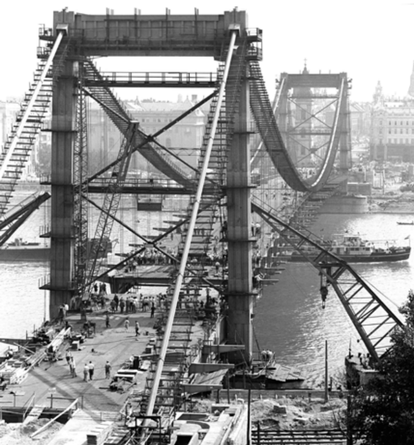
Budapest, 1964. július 15. Helyére emelik az Erzsébet híd utolsó pályaszerkezeti elemét is. A híd – melyet Sávoly Pál (UVATERV) tervezett – Magyarország első kábelhídja és építése idején a világ legnagyobb nyílású (290 méter) lánchídja volt. MTI Fotó: Lajos György
